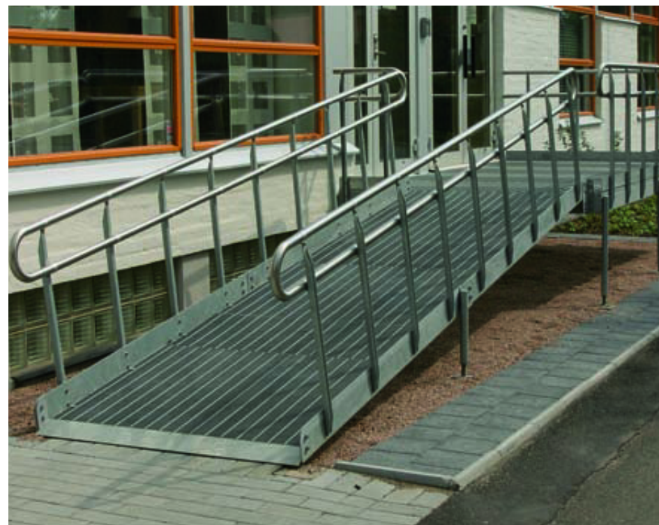
schemat budowy rampy
