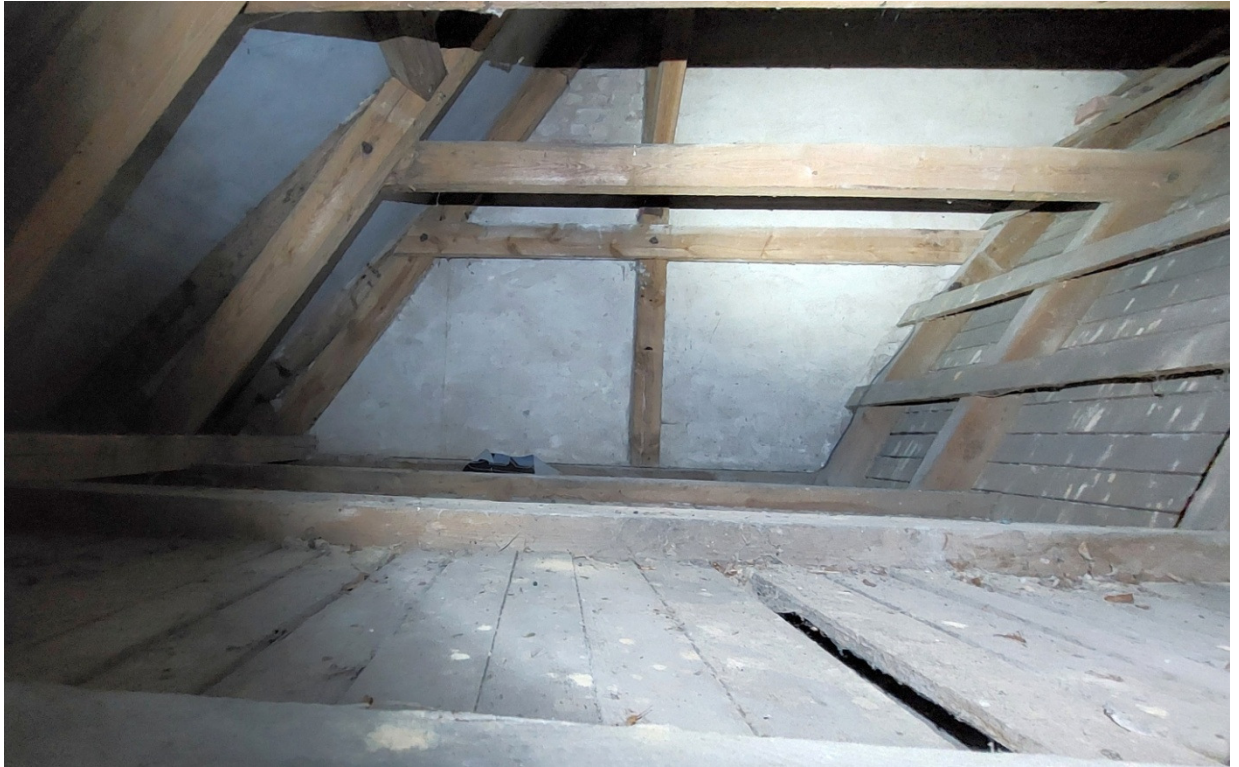
Zdj. 17. Belkowy, płaski strop drewniany nad zakrystią. Widoczne
