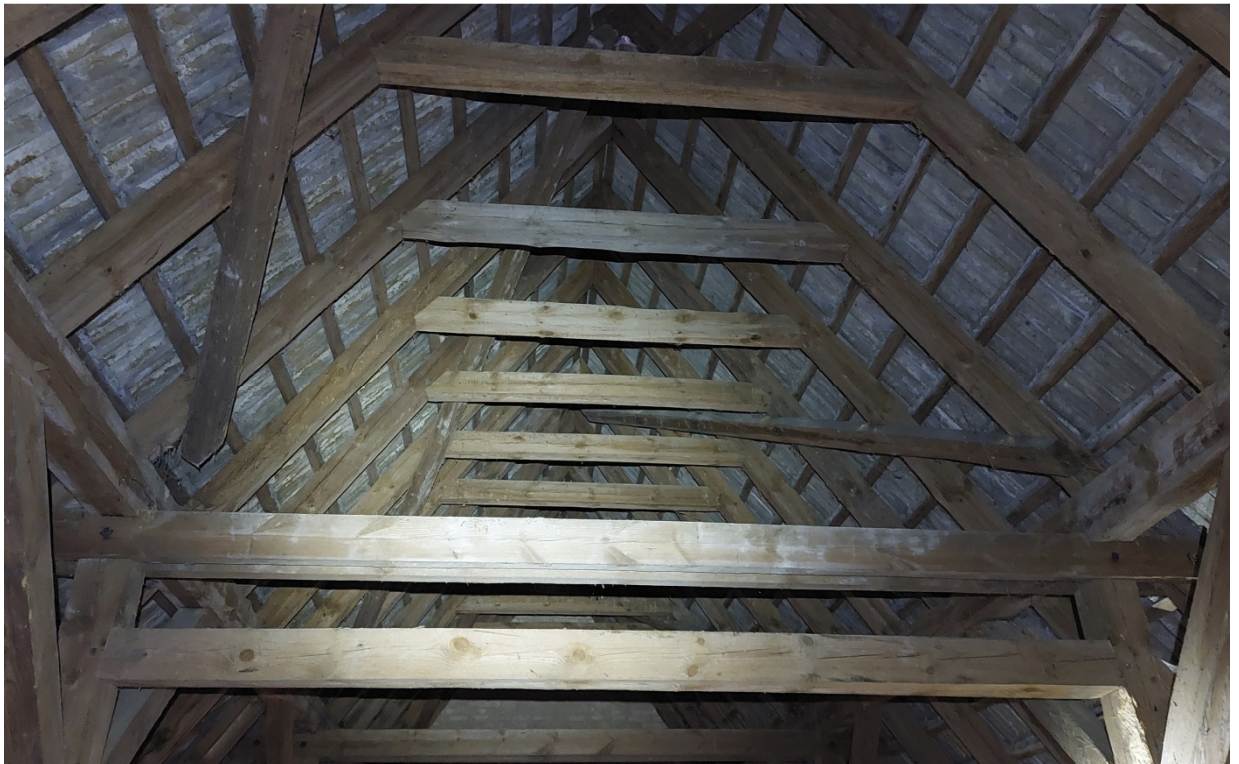
Zdj. 6. Widok na górny fragment drewnianego ustroju konstrukcyjnego nad nawą.
