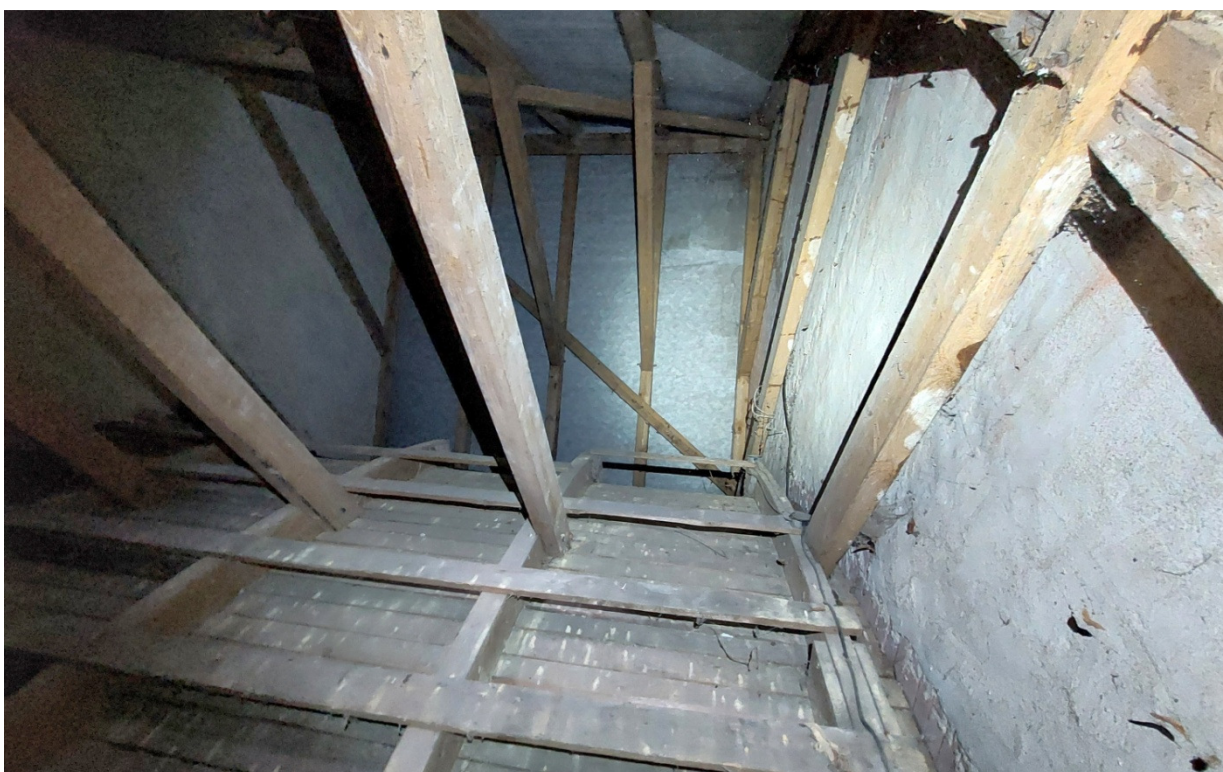
Zdj. 16. Widok na więźbę dachową i strop.
