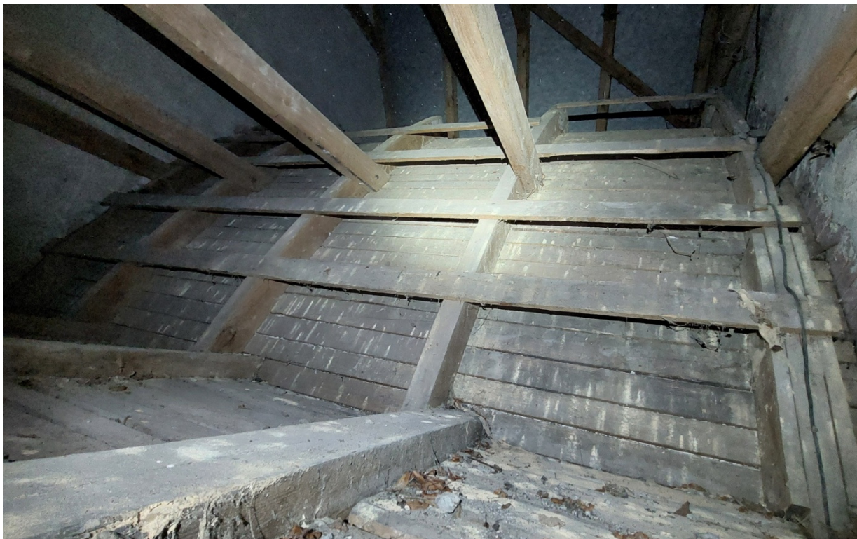
Zdj. 15. Drewniane stropy nad częścią prezbiterialną – płaski i ostrołukowy.
