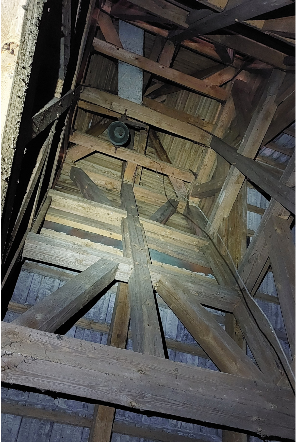
Zdj. 12. Konstrukcja wieżyczki z widocznym deskowaniem i dzwonem.
