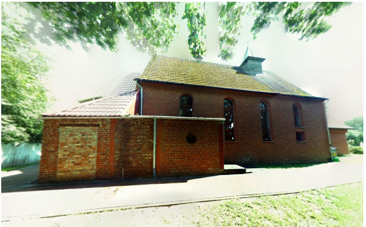
Zdj. 6. Widok od strony północnej z dobudówką z dachem płaskim krytym papą.
