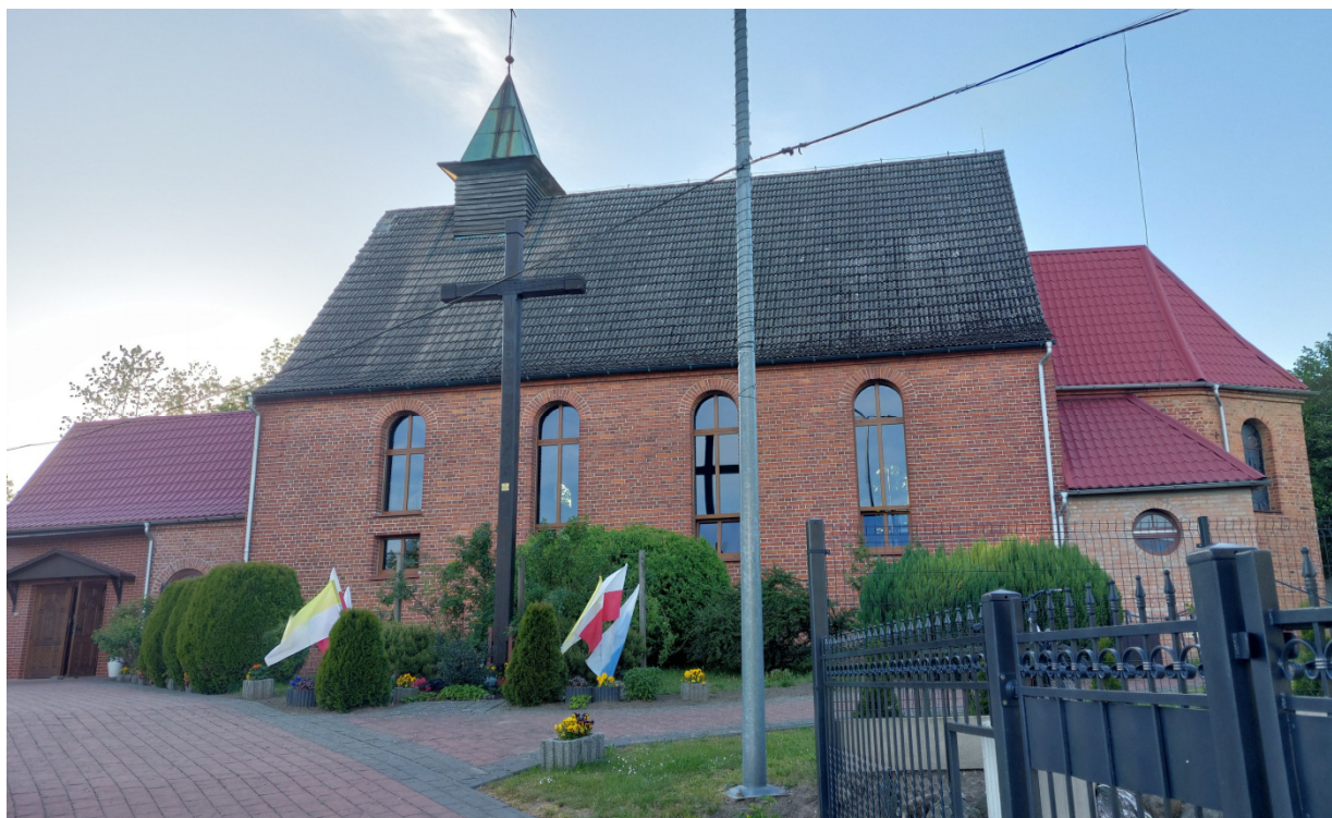
Zdj. 1. Elewacja południowa. Widok ogólny na bryłę i połącze dachowe od strony ulicy.
