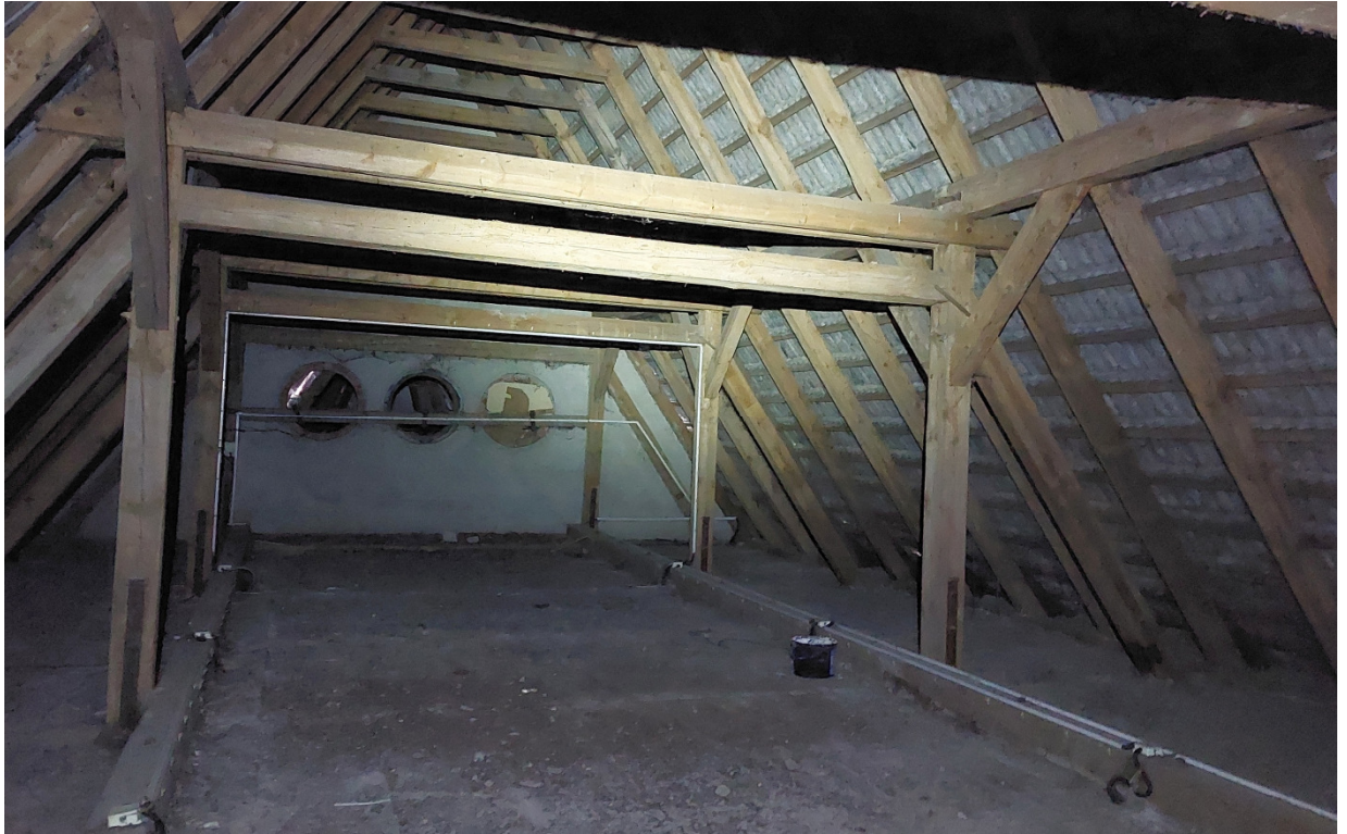
Zdj. 7. Widok ogólny na więźbę dachową i strych.
