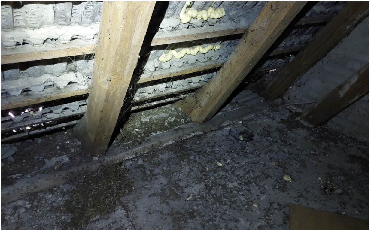
Zdj. 9. Bieżące uszczelnianie dachówek za pomocą pianki montażowej. Poniżej podłoga z płyt wiórowo-cementowych.
