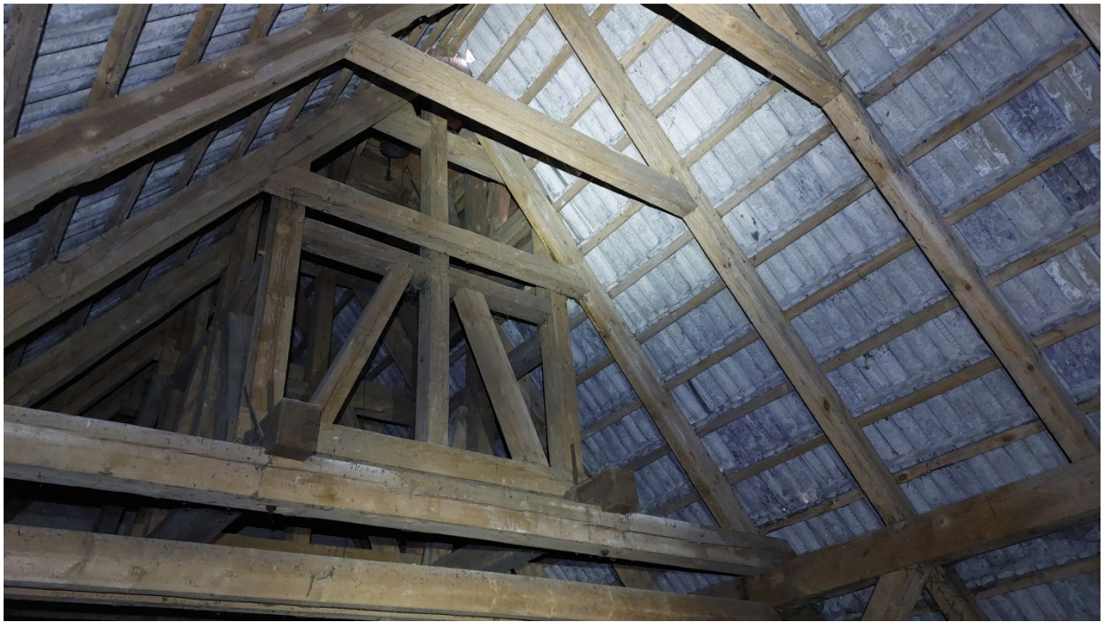
Zdj. 9. Miejsce oparcia konstrukcji wieżyczki na belkach drewnianych.
